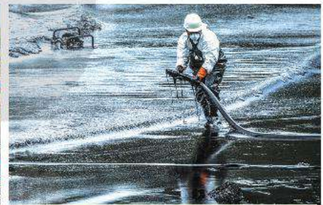
Hình 22.4. Sử dụng vi khuẩn phân huỷ dầu để xử lí sự cố tràn dầu trên biển
